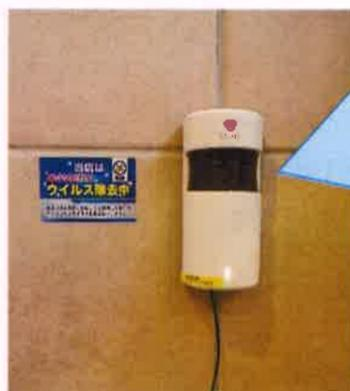
低濃度オゾンとマイナスイオンで、ウイルスや化学物質を分解して、空気の除菌・消臭をする【オゾン発生器】を館内トイレ4箇所とトレーニング室内と更衣室2箇所の合計7台設置。
