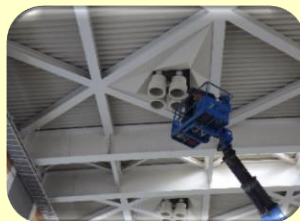
既存照明灯取り外し
