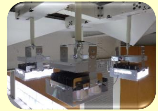
LED照明灯取り付け
